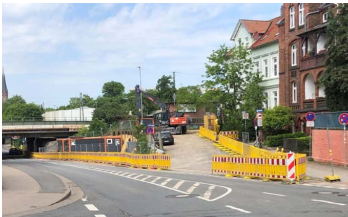
02.06.2021: Baustelle vom „Pulverweg“ aus gesehen
