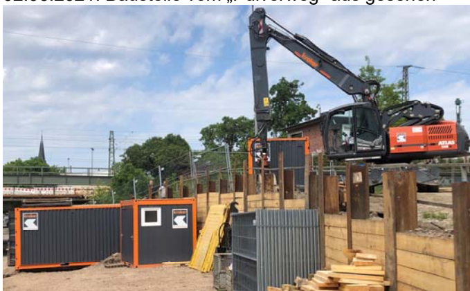
02.06.2021: Trägerbohlwand zur Abfangung der benachbarten Straße; Container- und Materiallager
