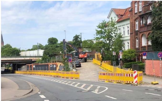
02.06.2021: Baustelle vom „Pulverweg“ aus gesehen
